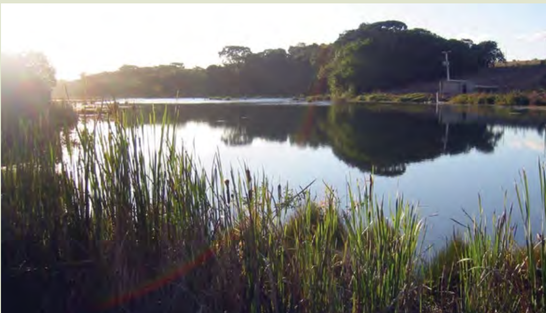
FIGURA 2 – Vista de uma pequena barragem, com características típicas das barragens utilizadas para irrigação, localizada na Bacia Hidrográfica do Rio Preto
