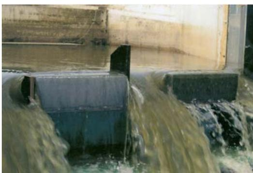
Em sua palestra, Peter Lee mostrou novas tecnologias de segurança utilizadas na construção de barragens como vertedouros 'teclado de piano' e os 'fusíveis de concreto'
